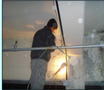
지하 주차장 천장 방수
