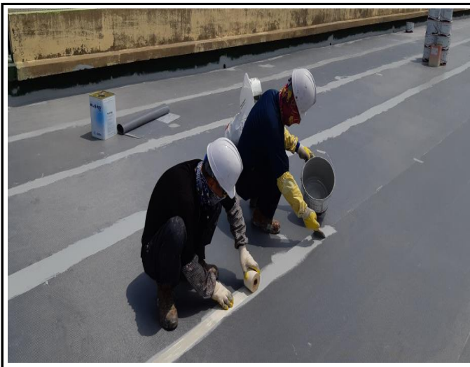
FAV복합시트 연결부 보강작업
