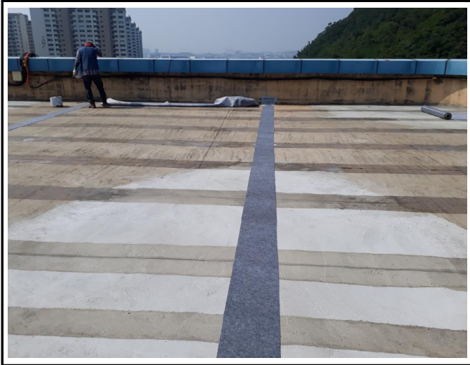
프라이머 도포 후, 에어벤트 설치작업
