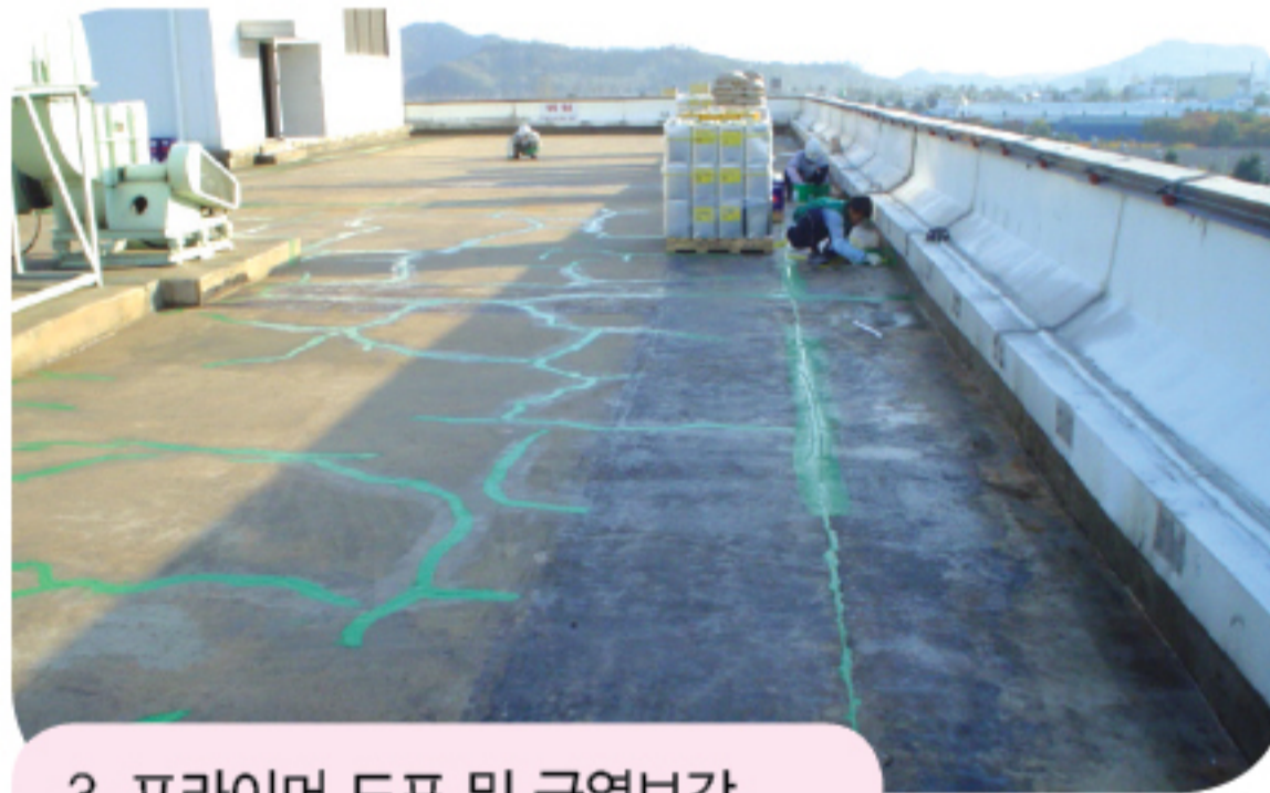
3. 프라이머 도포 및 균열보강
