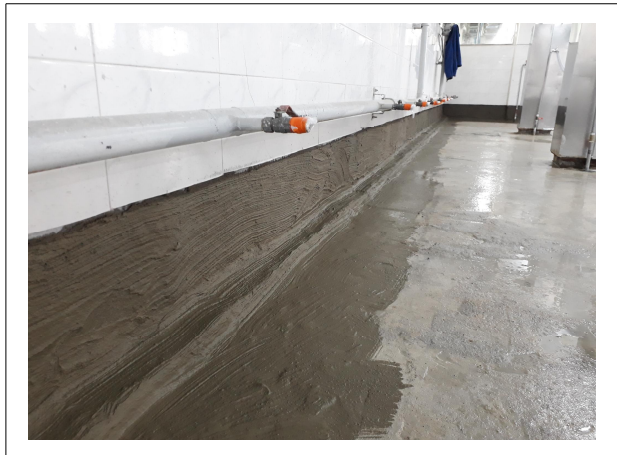
벽면 방수처리작업 후
