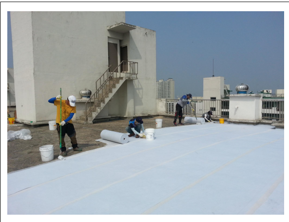
방수제 도포 및 시트 부착작업
